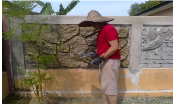
Gambar 10. Contoh produk 'tembok/pagar rumah' yang sedang dibina dari simenfero yang dicampur Red Clay dan Putty Filler.
